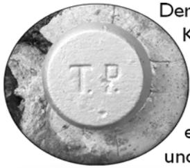
Der tonnenförmige Kopf hat einen Durchmesser von 66 mm, ist aus Schmiedeeisen hergestellt und trägt als Turmbolzen die Inschrift „T.P.“ (Trigonometrischer Punkt).
